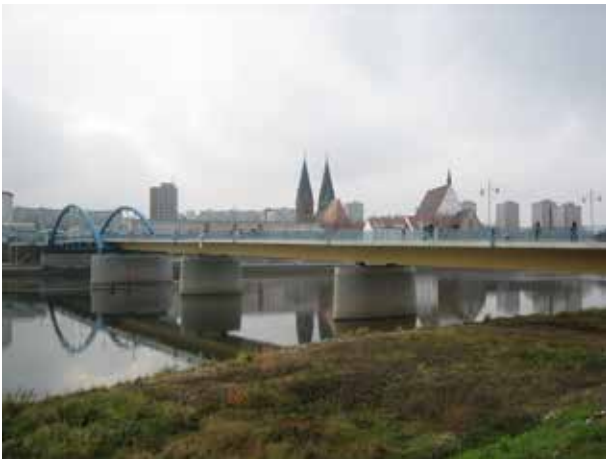
〔図2〕 フランクフルト・オーダーとスウビツェをつなぐ橋 (出典) 著者撮影、対岸の街並みがフランクフルト・オーダー
